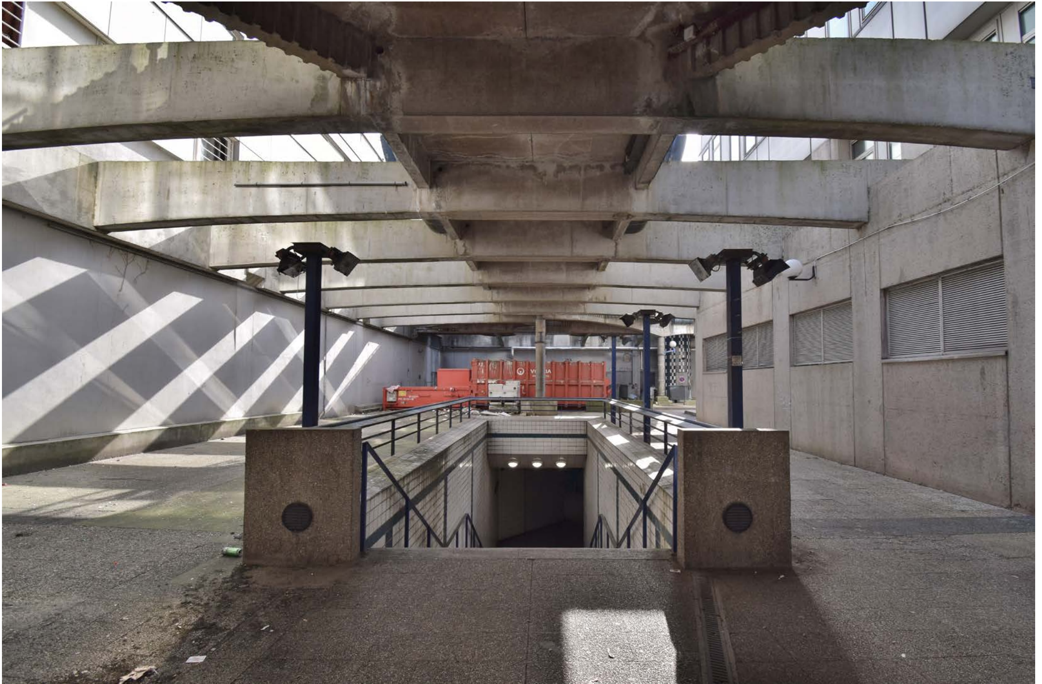
Accès RER A depuis la rue de la pergola
