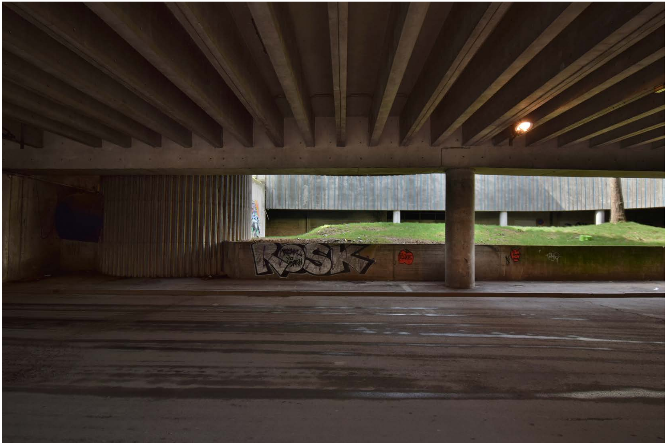
Le dessous de l'esplanade : ancienne gare routière
