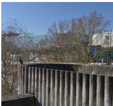
PHOTOGRAPHIE DE SITE
