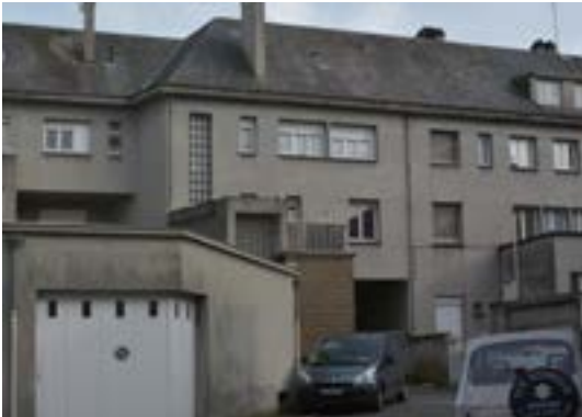
La façade du même immeuble côté cœur d'îlot révèle l'hétérogénéité du bâti de la reconstruction
