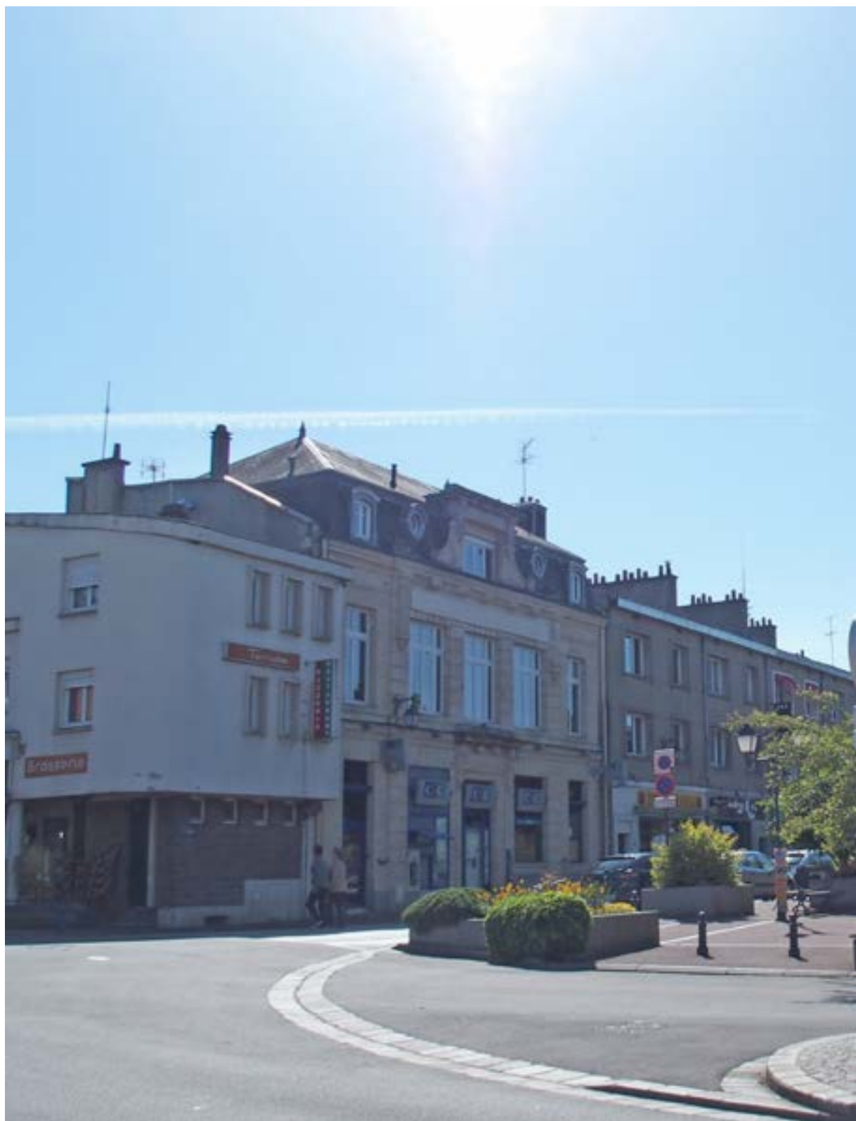
(6) La façade nord de l'îlot A8
