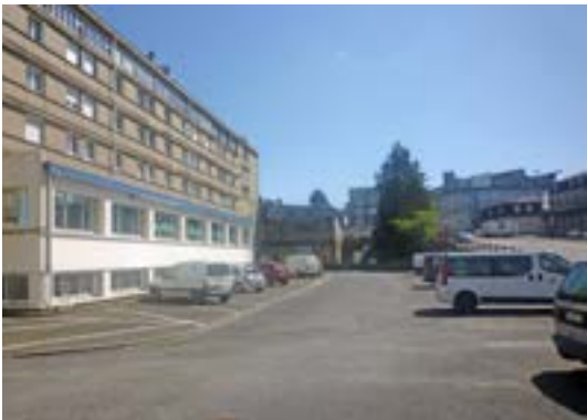
Arrière dévolu au stationnement donnant sur l'entrée de ville
