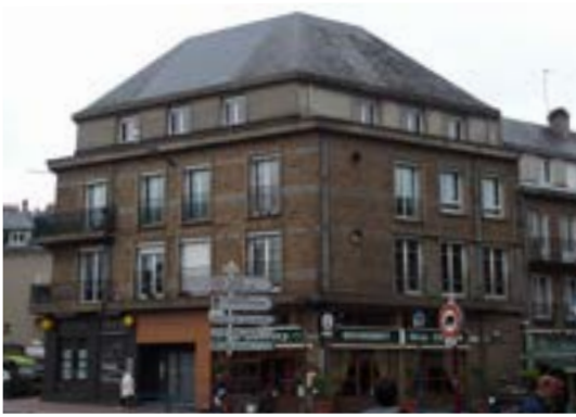
Ordonnement de façade sur la place du 6 juin 1944 : utilisation du granite local, étage en attique et toiture en ardoises
