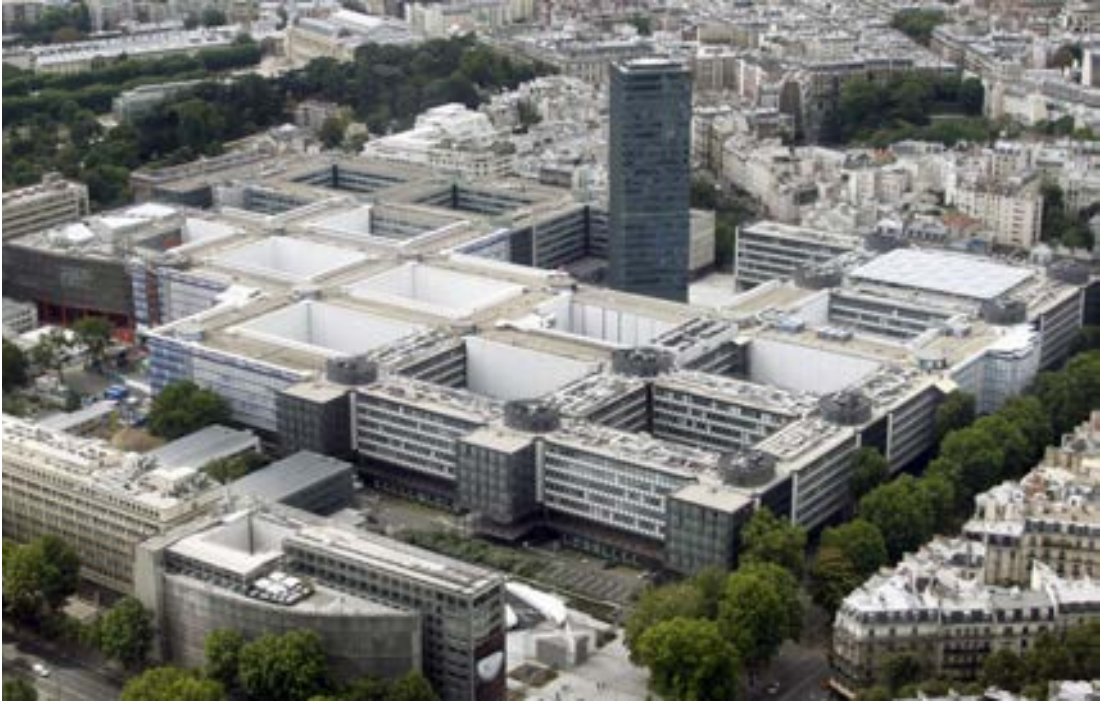
Faculté de Jussieu, Paris, travaux de désamiantage depuis 1995.
