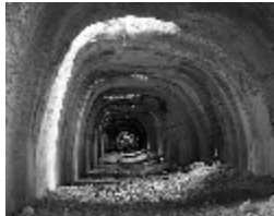
200 Galeries de service de Grand Trappeo Villa Adriana - 7m
