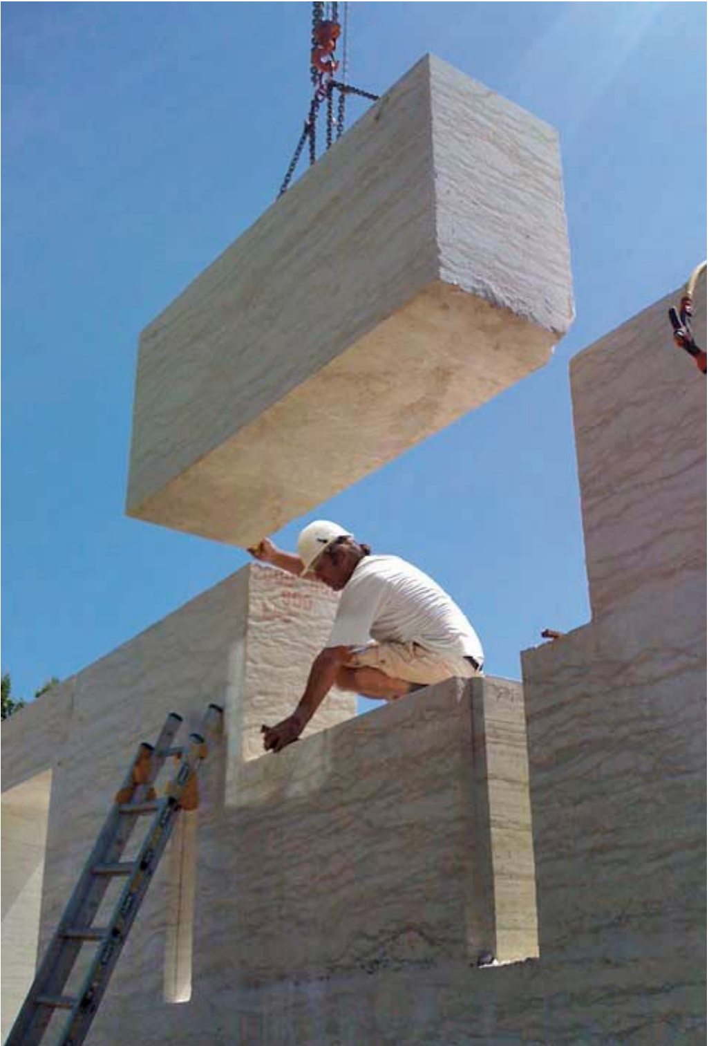
Assemblage de blocs de pierre dans un projet de Gilles Perraudin
