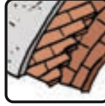
Voûte catalane en brique
