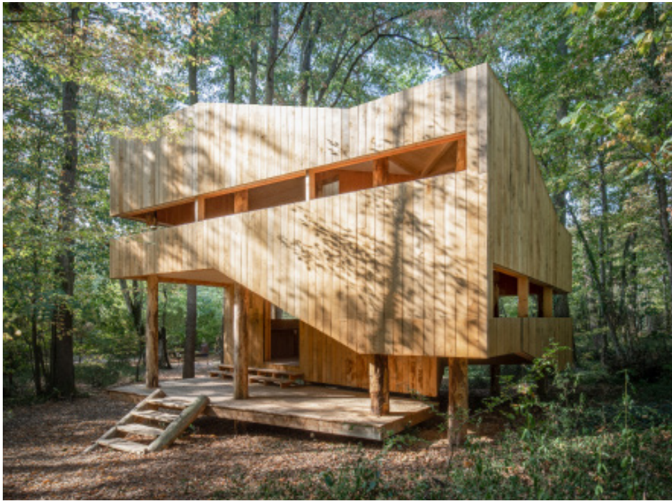
Maison 100% bois - Montlouis sur Loire (37) - 2020
