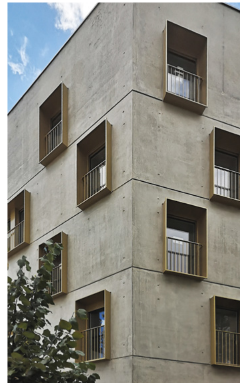
Résidence intergénérationnelle 78 Lgmts - Dijon (21) - 2022
