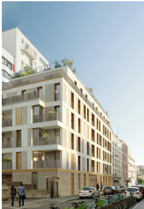
24 logements collectifs - Paris (75)
