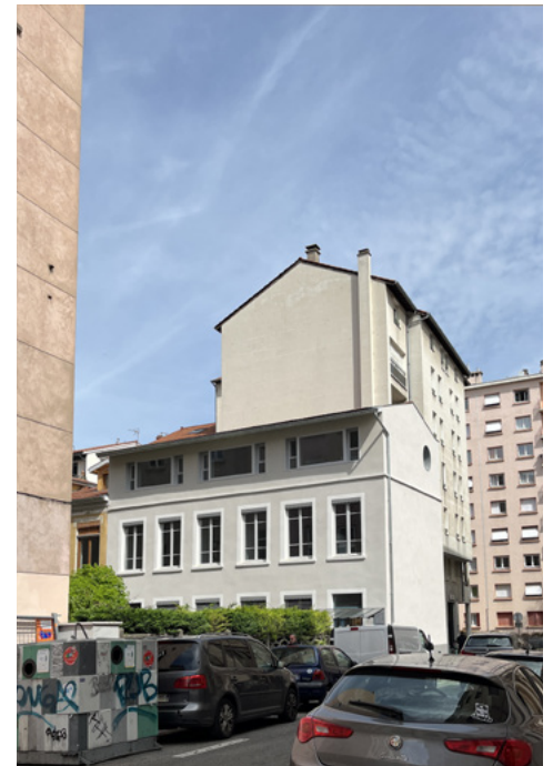
Réhabilitation et surélévation d'une maison - Lyon (69) - 2023
