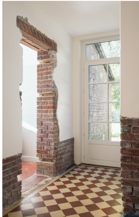
Rénovation d'une maison - Martin-Eglise (76) - 2022
