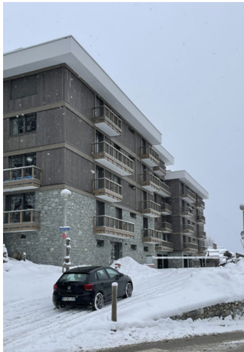
Rénovation d'un immeuble - Courchevel (73) - 2022
