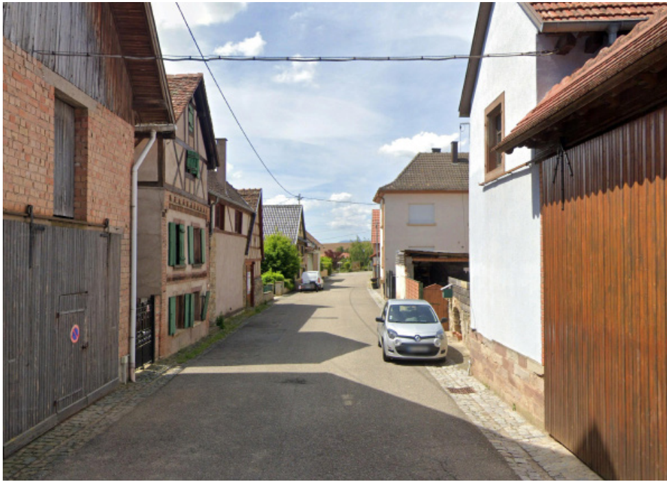
Sauvetage d'un soubassement sinistré et surélévation en bois vosgien - Durningen (93) - 2022 - en cours
