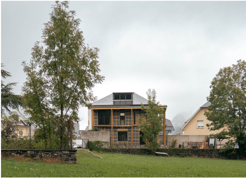
Construction d'une maison, réemploi de matériaux existant, auto-construction - Laruns (64) - 2024
