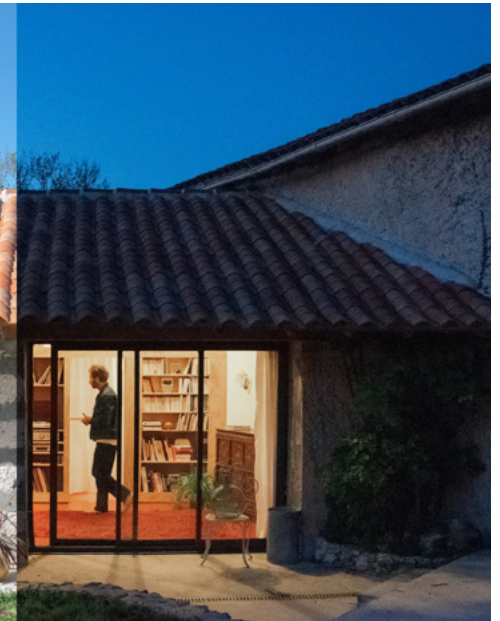
Rénovation d'une grange - Ribérac (24) - 2023
