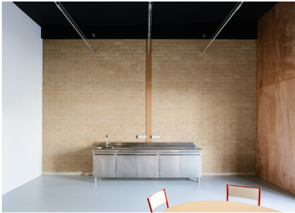
Transformation d'une ancienne halle de marché en maison de l'ESS - Bois et Terre crue - Garges (95) - 2023 - Photo P. Billard
