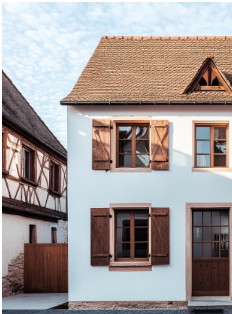
Accompagnement AMO pour la rénovation globale - Depuis 2024
