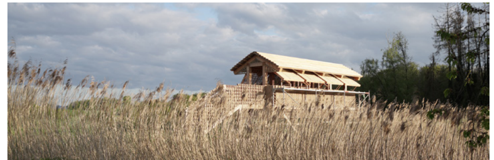
l'observatoire des étangs de Nérac - construction bois et roseau - Altenach (68) - 2023-2024
