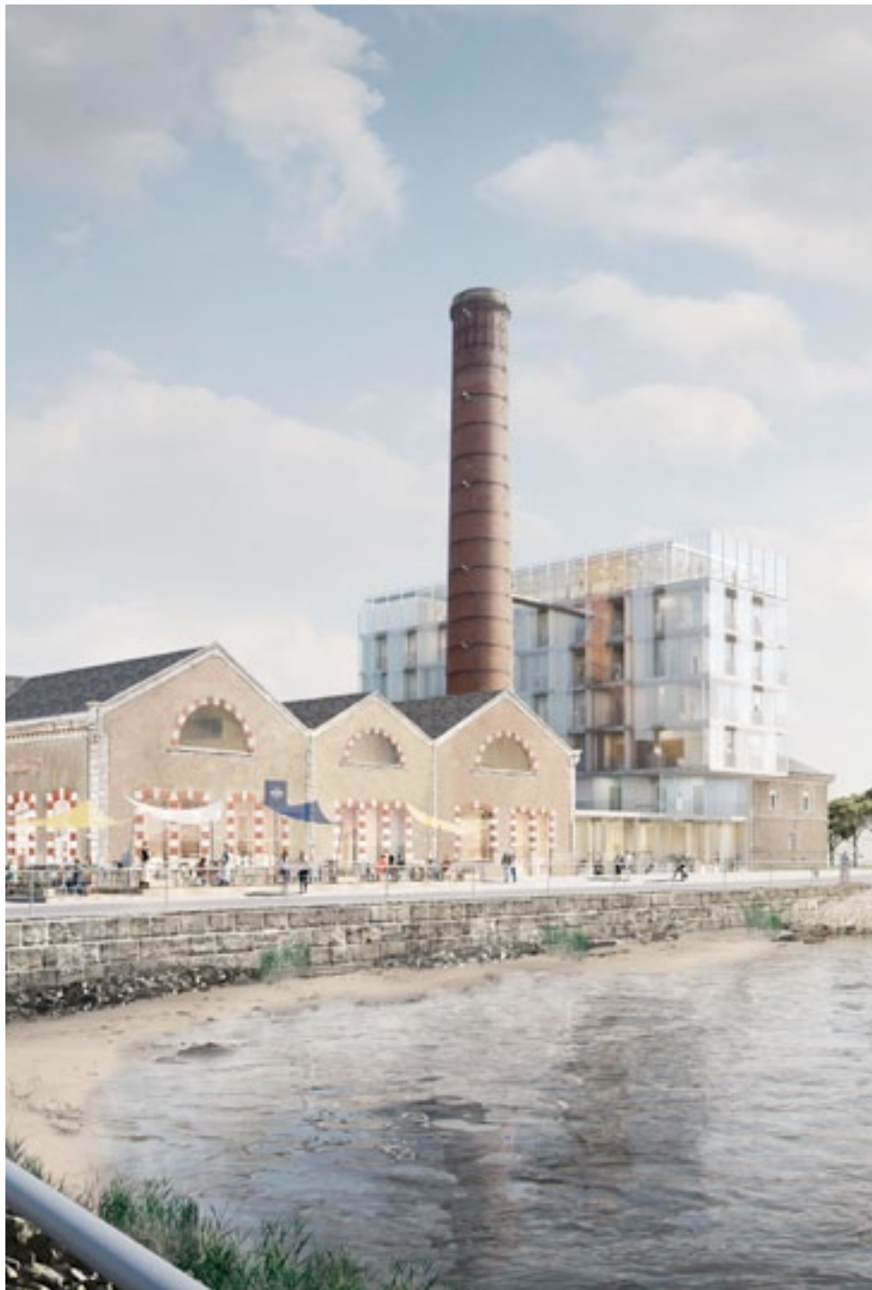
Réhabilitation de l'usine élévatoire du port de Saint-Nazaire
