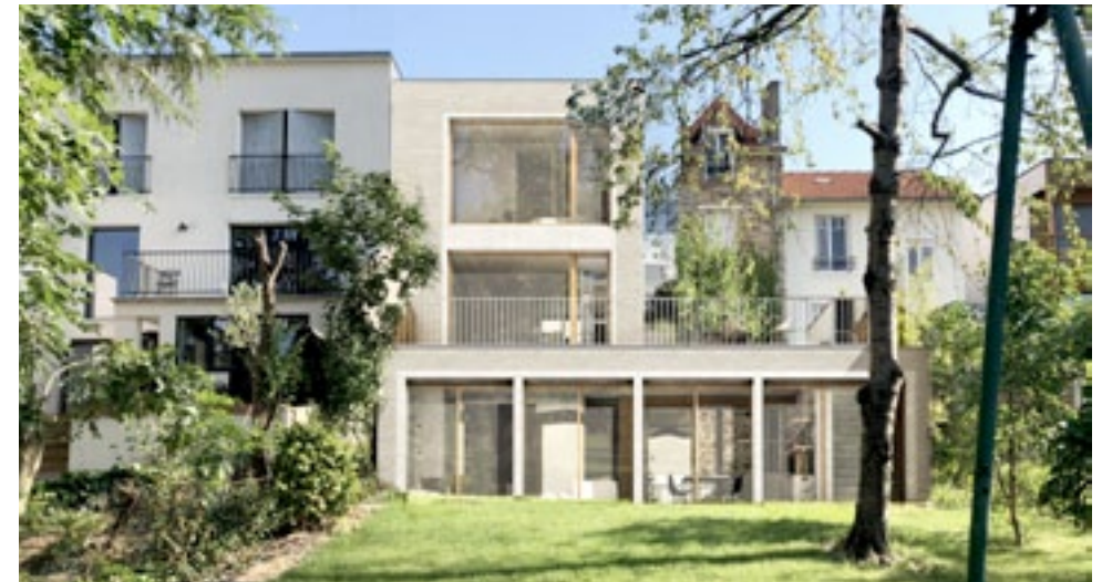
Maison à Garches- Meulière de ré-emploi - Maison passive - 2019
