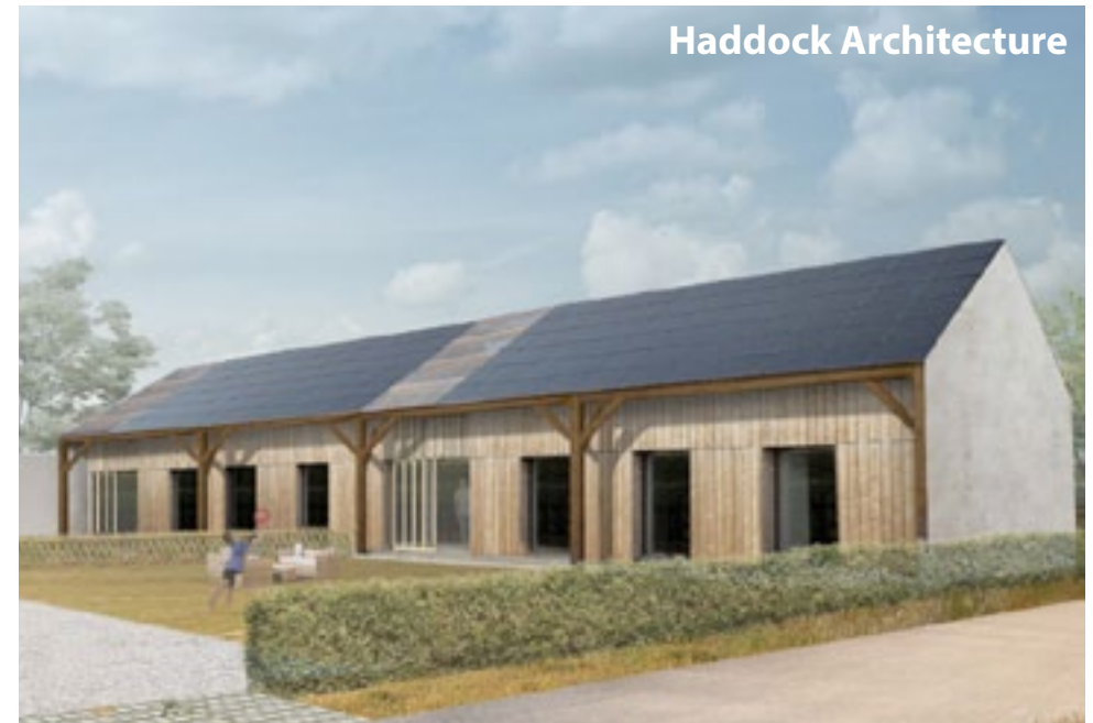
Transformation d'un hangar en 2 maisons - Chantepie - Charpente existante, structure bois, toiture photovoltaïque - 2020
