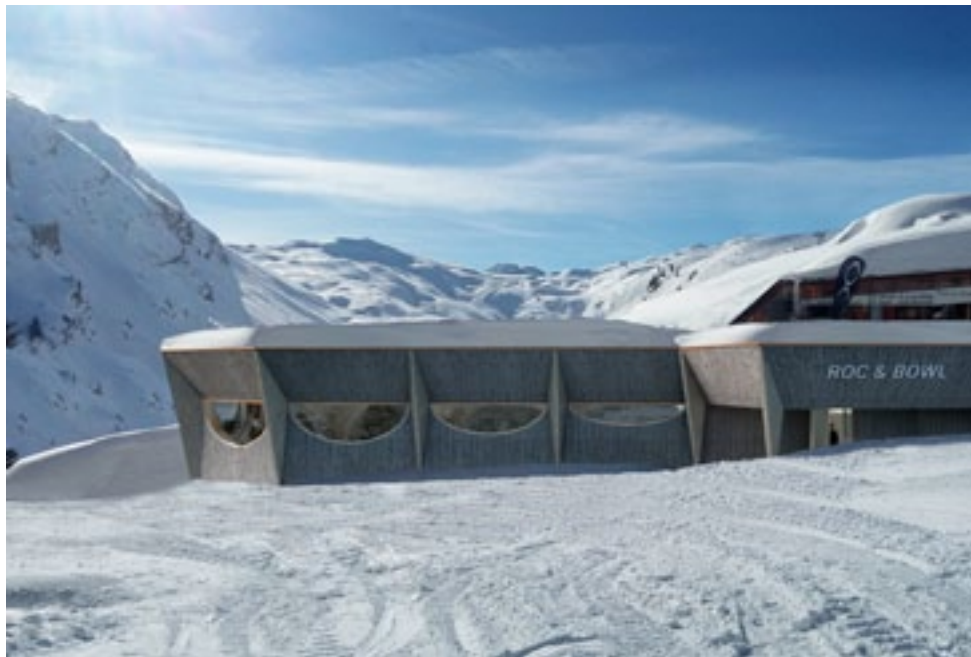
Extension et rénovation d'un bowling bar, restaurant à Avoriaz LE ROC & BOWL - 2019
