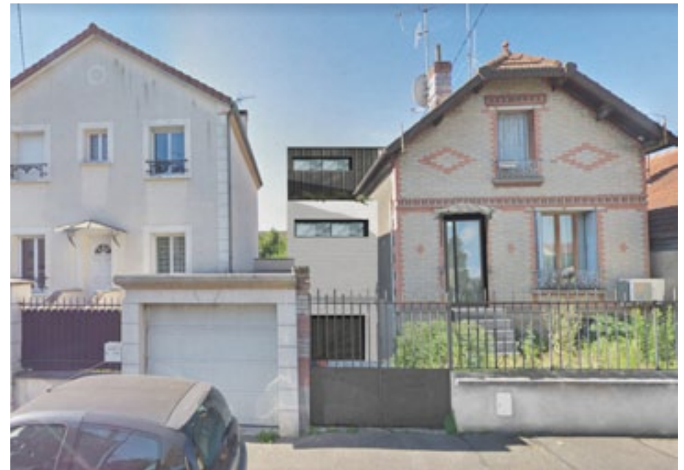
GVL (94) Extension d'une maison classée 95 m 2 neuf / 70m 2 rénovation 200 000 € HT Etudes en cours
