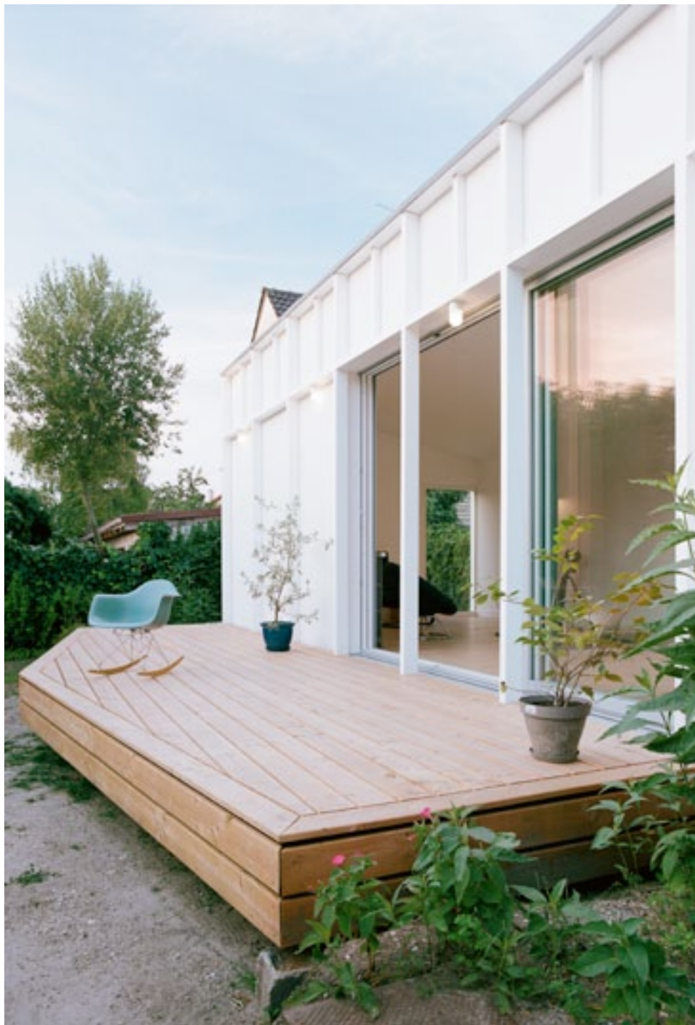
Extension d'une maison - Neully Plaisance - 2018
